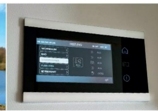
Steuerung der Zentralheizung/Fußbodenheizung
